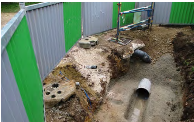
Les travaux terminés avec les bas côtés recouverts de gravillons
